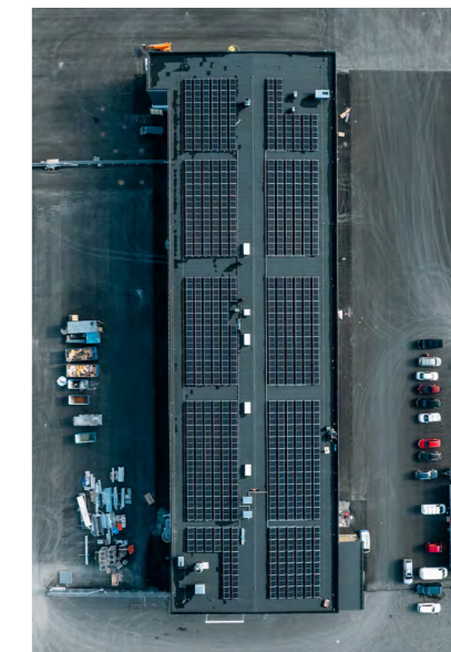
Solcellerna på taket är en viktig del av verkstadens energieffektiva och hållbara energisystem.
